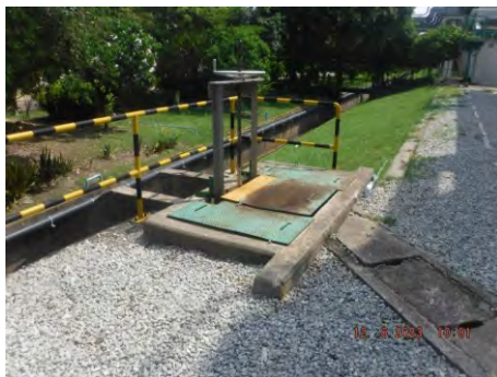
ภาพที่ 2.2-24ข รางระบายน้ำฝนที่เชื่อมต่อ กับรางระบายน้ำฝนของนิคมฯ
