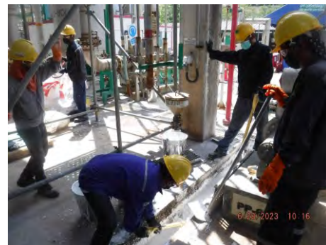
ภาพที่ 2.2-25ข การขุดลอกรางระบายน้ำฝน
