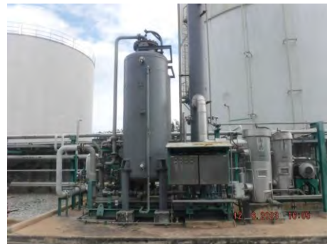
ภาพที่ 2.2-6ข หอดูดซับสารอินทรีย์ระเหยง่าย (VRU)
