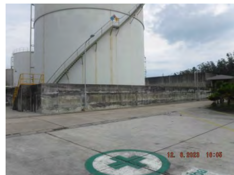
ภาพที่ 2.2-54x กำแพงกันสารเคมี เพื่อป้องกันสารเคมีหกรั่วไหล
