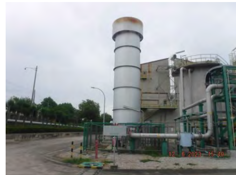
ภาพที่ 2.2-18ข หอเผา (Flare) และรั้วกั้นรอบหอเผา
