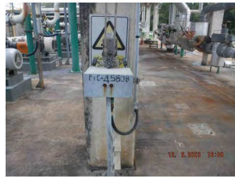
ภาพที่ 2.2-21ข ระบบ Flow Meter
