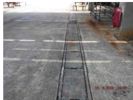
ภาพที่ 2.2-23ข รางระบายน้ำฝนภายในโรงงาน
