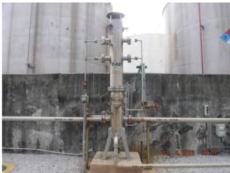
ภาพที่ 2.2-5ข Seal Pot บริเวณถังเก็บกรดอะซิติก
