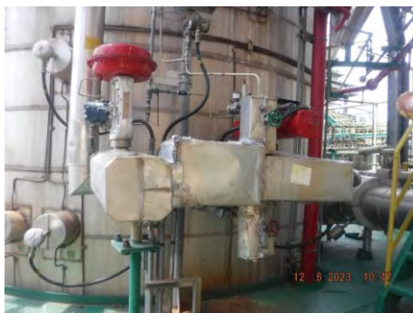
ภาพที่ 2.2-53x Shut Down Valve และ Safety Valve
