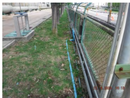
ภาพที่ 2.2-19ข ท่อส่งน้ำทิ้งหลังการบำบัดน้ำมารดน้ำต้นไม้
