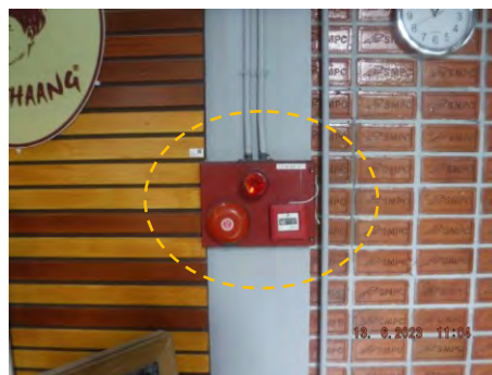
ภาพที่ 2.2-43x อุปกรณ์เตือน-ชีวัด (Alarm)
